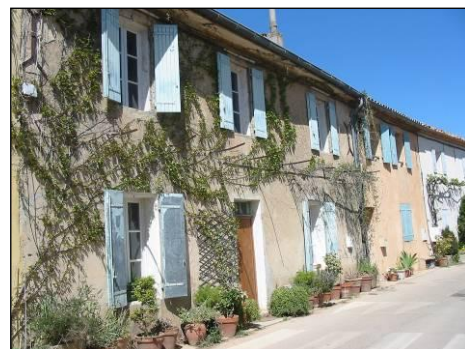
La maison de village jointive et alignée
