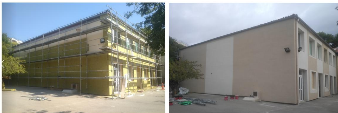
Isolation par l'extérieur de l'école élémentaire Jules Payot
