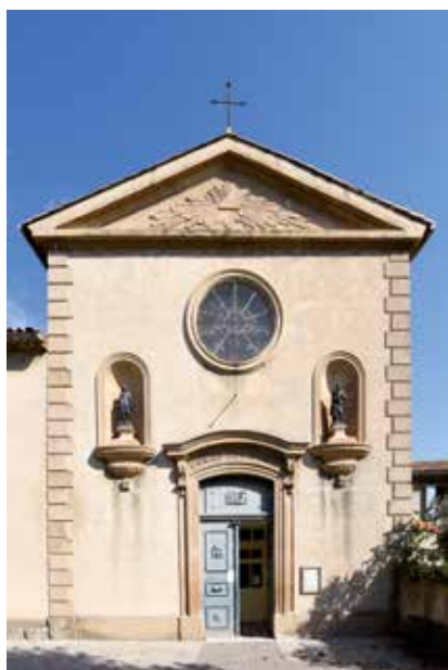
La façade de l'église a quant à elle été restaurée en 2015.
