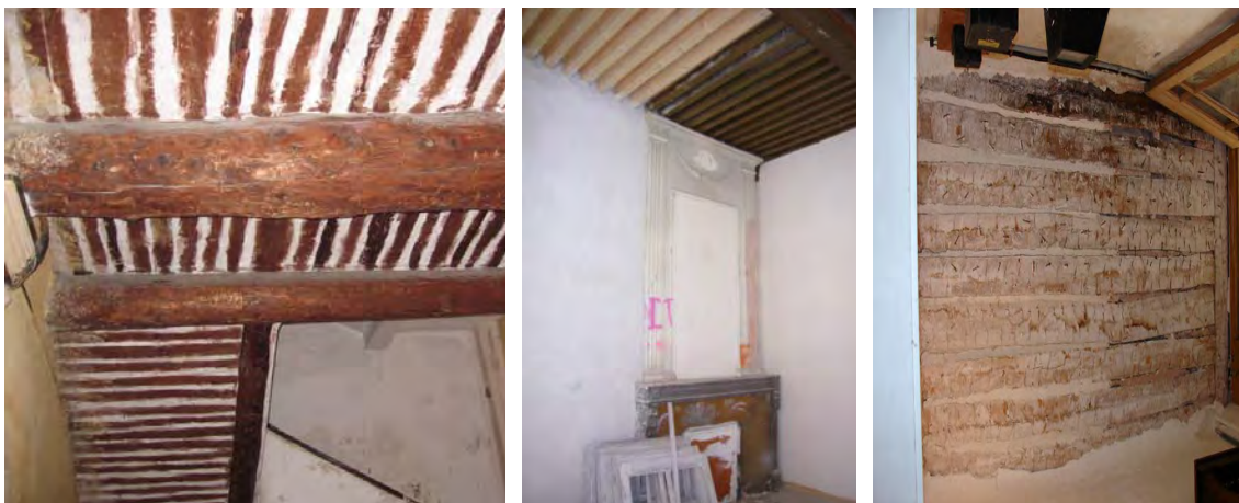
Exemples de disposition de planchers, cliché GF.
