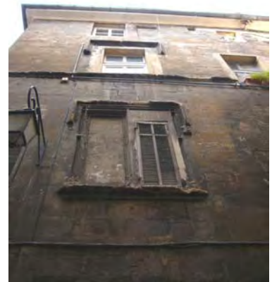
Hôtel de Périer, fenêtres à meneaux remaniées, rue Rifle-Rafle, cliché S.J.
