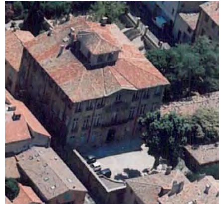
Toitures plus complexes sur les édifices majeurs..
