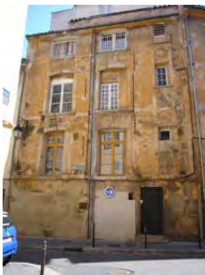
Enduit traditionnel à la chaux et badigeon de chaux ocre jaune
