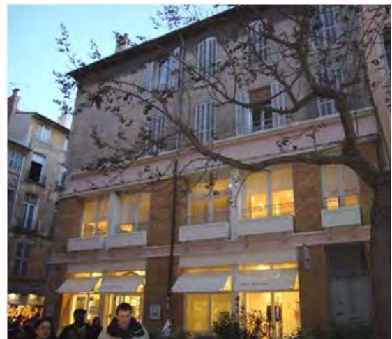
Place des Chapeliers la façade commerciale est aménagée sur deux niveaux, elle ne respecte pas la composition.
