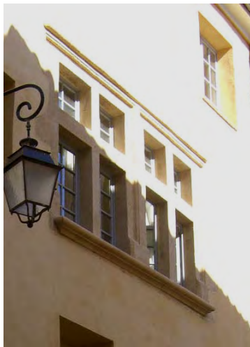
Rue de l'Annonerie-Vieille fenêtres à meneaux pierre XVIe, menuiseries à petits carreaux.
