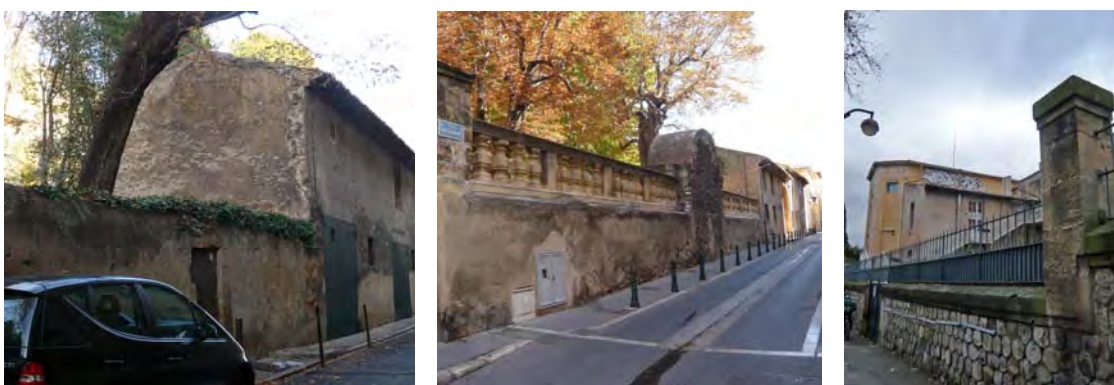
Photographies du quartier Mazarin, les murs de clôtures sont surmontés d'un glacis, de balustrades ou de grilles avec pierre de couronnement, cliché V.W.
