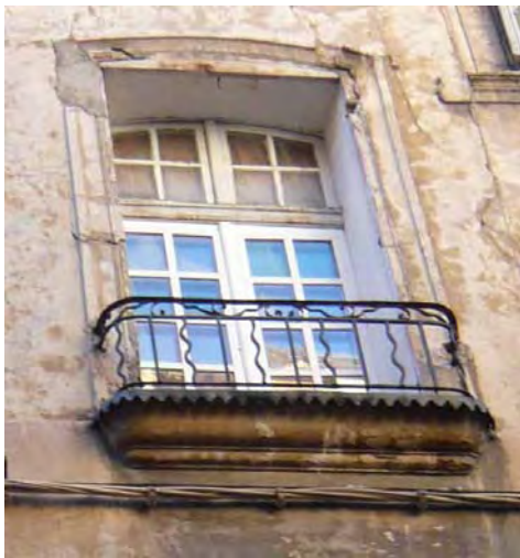
Ci-dessus exemples de couvertines plomb et zinc sur partie saillante, cliché VW.
