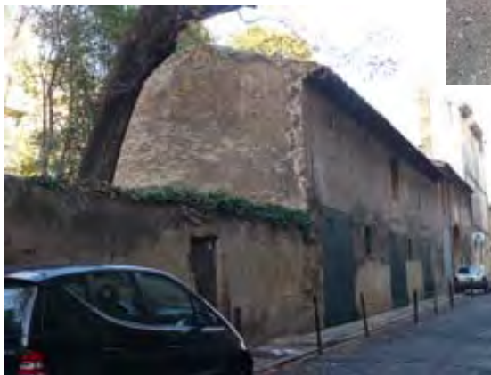
Pignon traité avec un enduit ancien : chaux et sable de rivière
