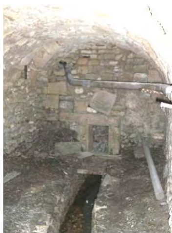
Cave voûtée du 2 rue F. Mistral cliché GF
