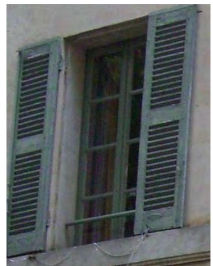
2 rue Manuel, baie à linteau droit XIXe menuiseries à grands carreaux.
