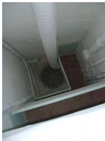
Puits de lumière occupé une gaine d'extraction.
