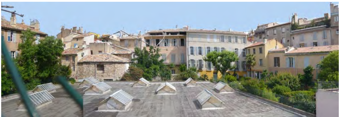
Photographies de la partie Nord de l'îlot, au premier plan le toit de l'entrepôt, au second plan les façades arrière des hôtels particuliers de la rue des Cordeliers et les jardins, cliché V.W.
