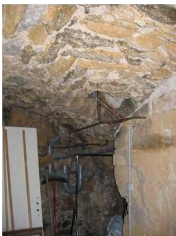
Ancien réseau de canalisation dans une cave du 7 rue Mignet cliché GF
