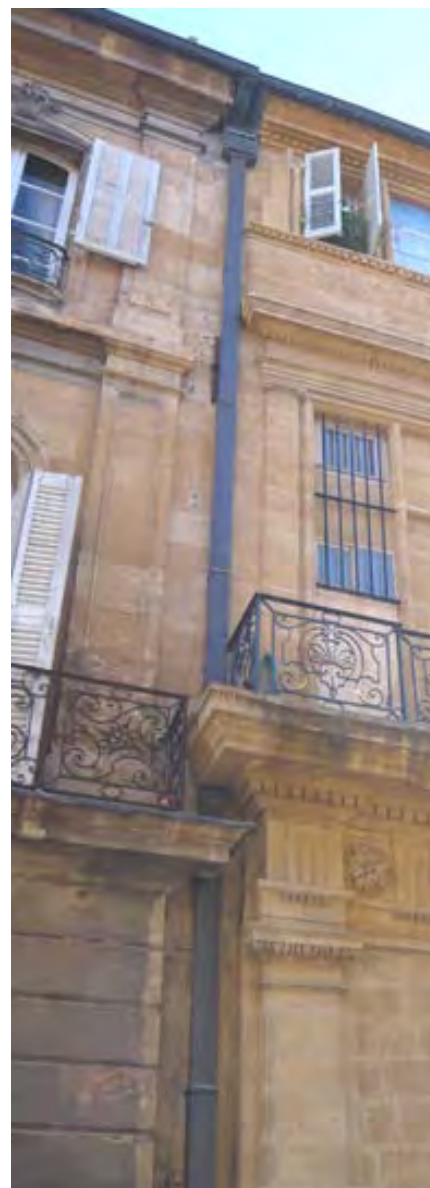
Raccordement entre gouttière et descente soudé à 60° ou 45°
