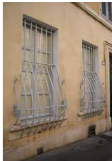
Grilles en fer forgé à restaurer, motif, assemblage et section de fer à respecter
