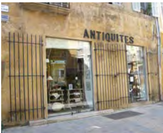
Exemples de grilles et de volets bois se rabattant de part et d'autre de la baie
