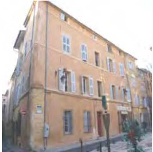
Encadrements et cordons en appui des baies
