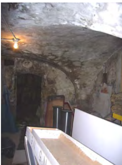
De gauche à droite : cave voûtée enduit ciment à écrouter ; escaliers d'accès cave en pierre à conserver, murs en moellons.
