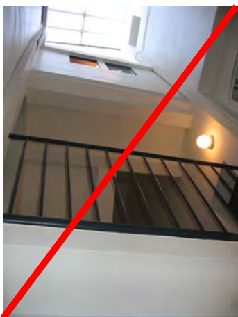
Puits de lumière à restituer ; galerie privatisée à restituer dans les parties communes, déposer les conduits d'extraction du puits de lumière et restituer la verrière
