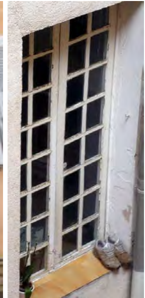
Menuiserie à deux vantaux cintrés, petits carreaux
