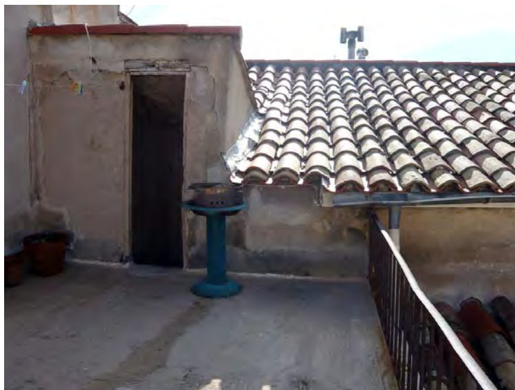
Dispositions traditionnelles d'accès en toiture, ci-dessus accès vers une terrasse
