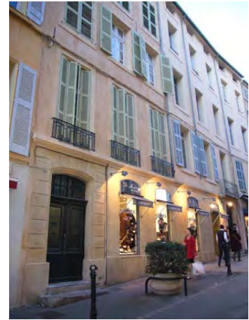
Stores placés en tableau de chaque baie
