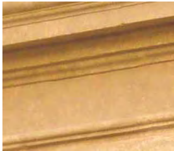
Traces de coloration à l'abri des intempéries : sous la corniche ; sous les moulures.
