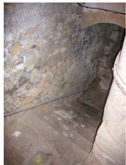
De gauche à droite : cave voûtée enduit ciment à écrouter ; escaliers d'accès cave en pierre à conserver, murs en moellons.
