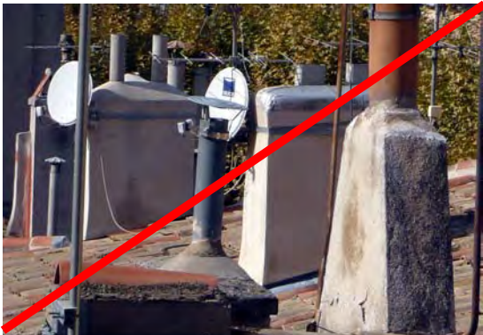
Antennes posées en toiture à intégrer dans le volume des combles
