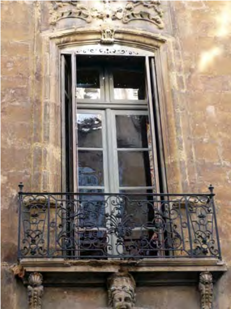
Appuis de porte-fenêtre sur consoles et mascaron
