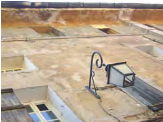
Traces de coloration à l'abri des intempéries : sous la corniche ; sous les moulures.
