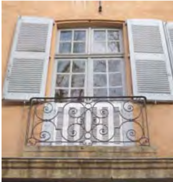
Menuiserie à deux vantaux cintrés, petits carreaux et imposte ouvrant
