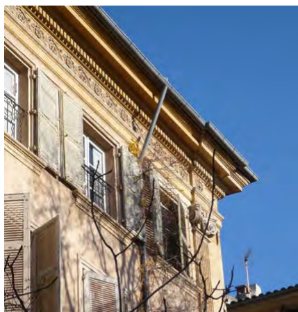
Raccordement entre gouttière et descente sur corniche moulurée
