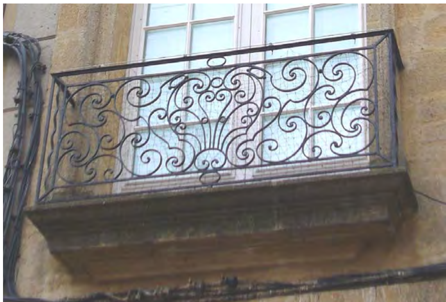
Ferronnerie de garde corps à restaurer, motif et section de fer à respecter, couvertine plomb ou zinc en protection d'appuis à poser
