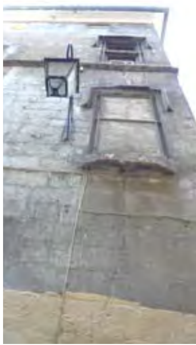
Ancienne baie à traverse bouchée
