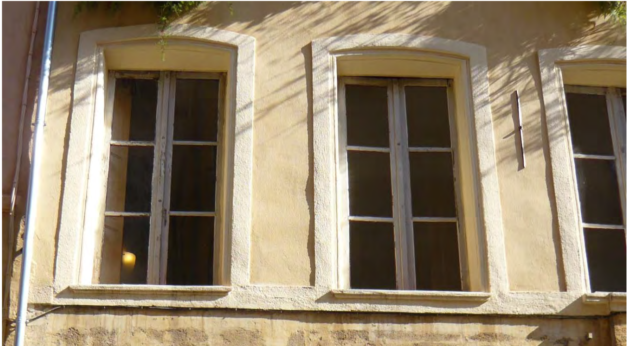
Menuiserie à deux vantaux, grands carreaux tiercés
