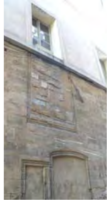
Ancienne baie à traverse bouchée
