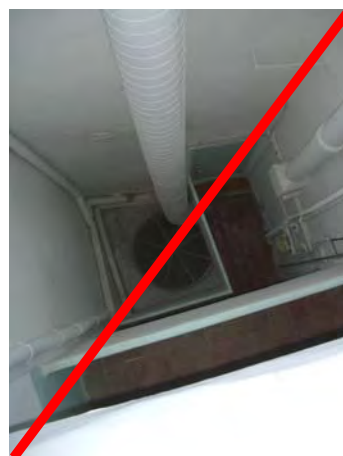
Puits de lumière à restituer ; galerie privatisée à restituer dans les parties communes, déposer les conduits d'extraction du puits de lumière et restituer la verrière
