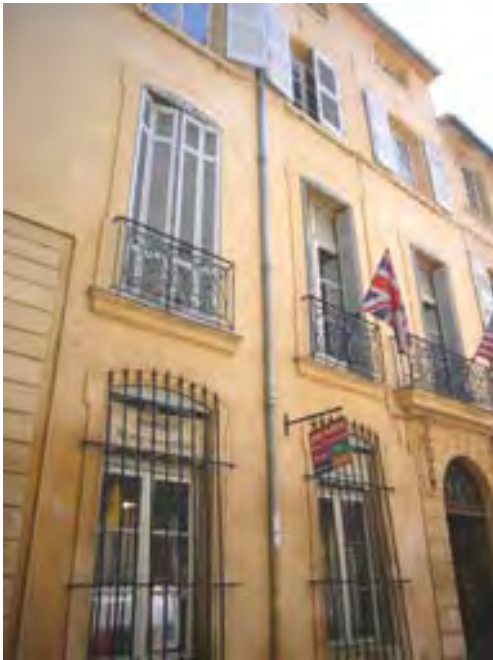
Grilles en fer forgé à restaurer, motif, assemblage et section de fer à respecter
