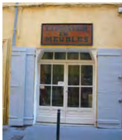
Exemples de grilles et de volets bois se rabattant de part et d'autre de la baie
