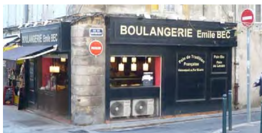
Exemples de climatiseurs en imposte en haut ; en allège (la grille est manquante sur la photo) en bas
