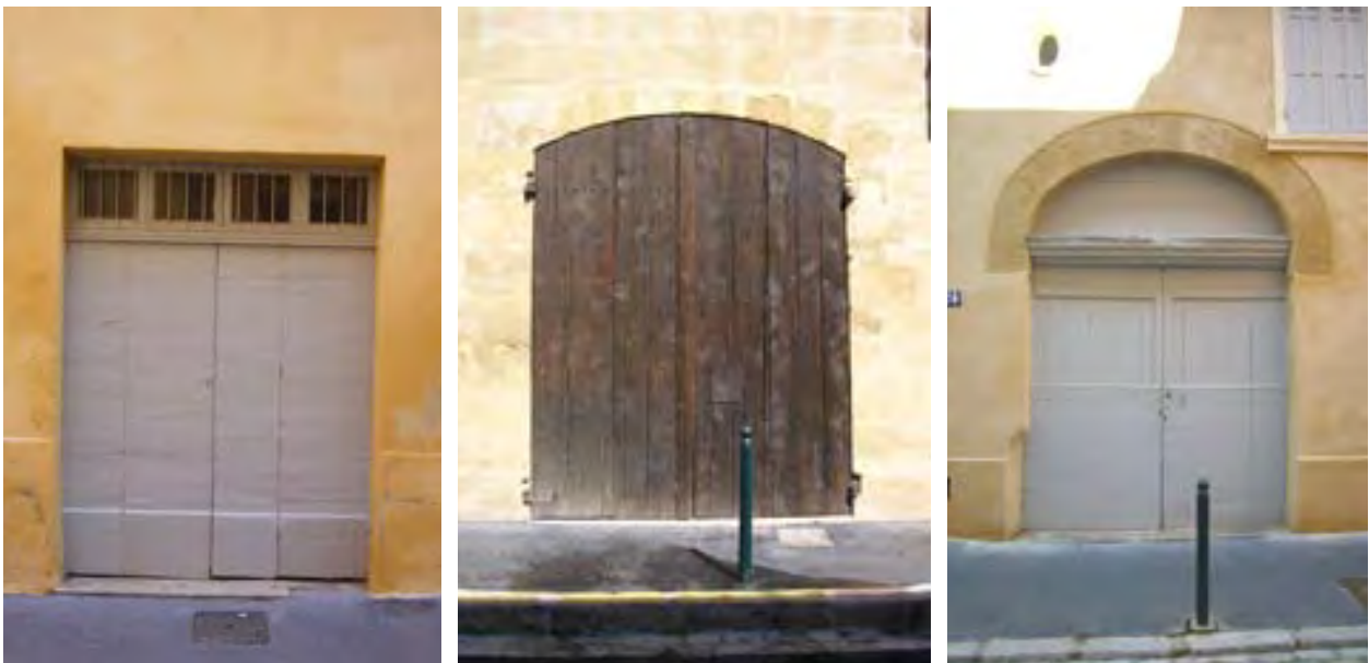
Anciennes portes de remise à restaurer : portes traditionnelles à double lames contrariées
