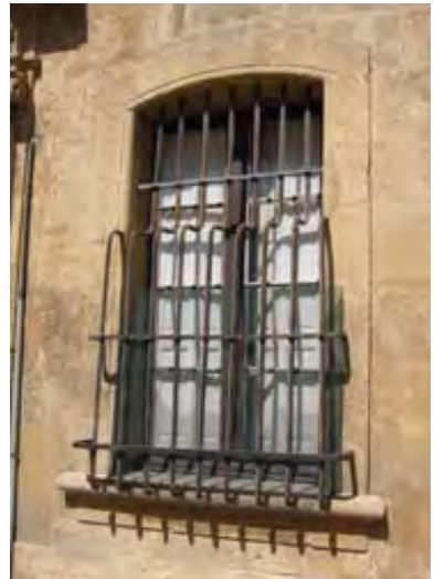
Grilles en fer forgé à restaurer, motif, assemblage et section de fer à respecter
