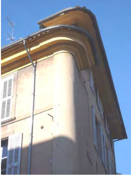
Corniches moulurées et croquis de principe : corniche moulurée avec chéneau et corniche à modillons
