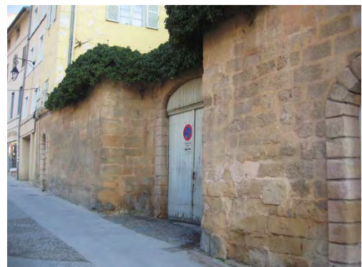
Exemples de murs de clôture en maçonnerie
