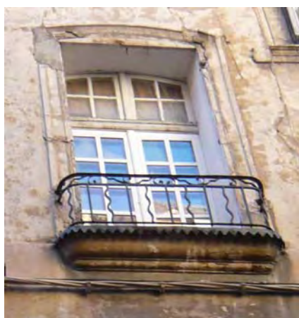
Ferronnerie de garde corps à restaurer, motif et section de fer à respecter, couvertine plomb ou zinc en protection d'appuis à poser
