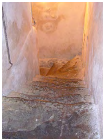
De gauche à droite : cave voûtée enduit ciment à écrouter ; escaliers d'accès cave en pierre à conserver, murs en moellons.
