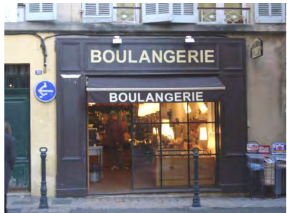
Croquis de principe et exemple de stores placés en tableau de la baie sous le caisson de la façade coffre
