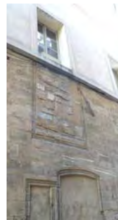
Fenêtres à meneaux et à traverse bouchées à réouvrir et à restituer
