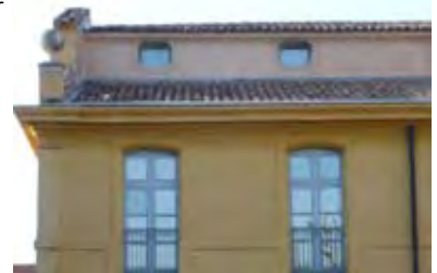
respect des travées de baies jusqu'au surcroît en retrait.
