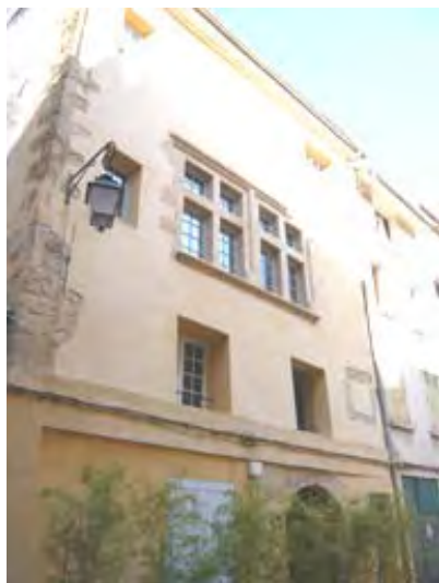
Fenêtres à meneaux restituées
