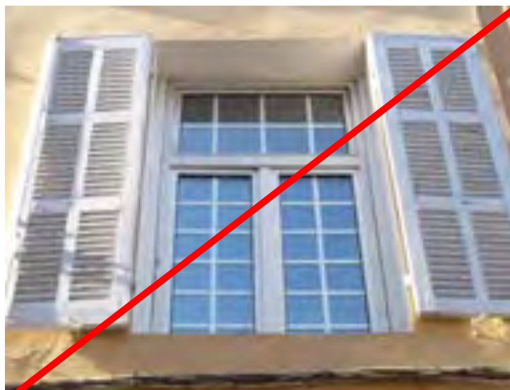
Menuiserie pvc avec petits bois collés sur le vitrage interdits
