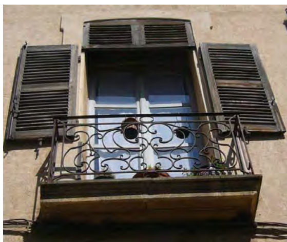
Garde-corps en ferronnerie et couvertines
