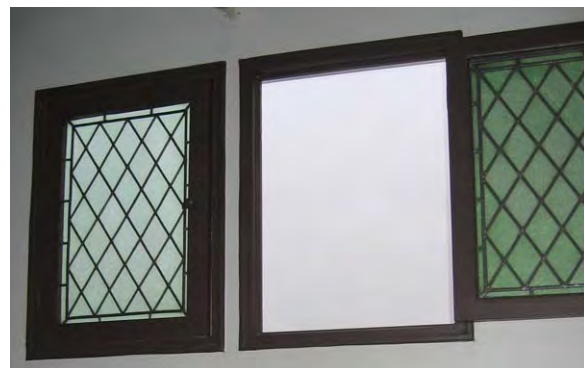
Vitrail serti au plomb sur croisée
