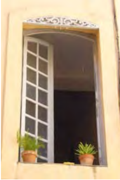
Menuiserie à deux vantaux cintrés, petits carreaux et lambrequin en bois sculpté
