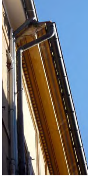
Corniches moulurées et croquis de principe : corniche moulurée avec chéneau et corniche à modillons
