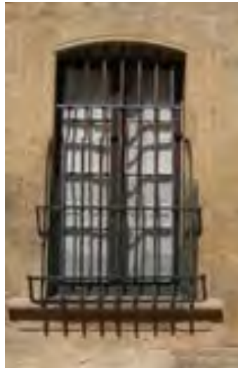
Grilles en fer forgé à restaurer, motif, assemblage et section de fer à respecter
