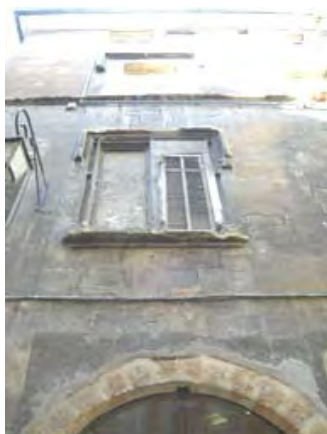
Fenêtres à meneaux et à traverse bouchées à réouvrir et à restituer
