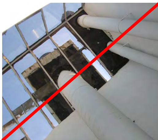
Puits de lumière à restituer ; galerie privatisée à restituer dans les parties communes, déposer les conduits d'extraction du puits de lumière et restituer la verrière
